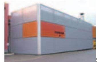
Le procédé de bardage textile Texo s'utilise sur n'importe quelle façade en béton ou maçonnerie.
